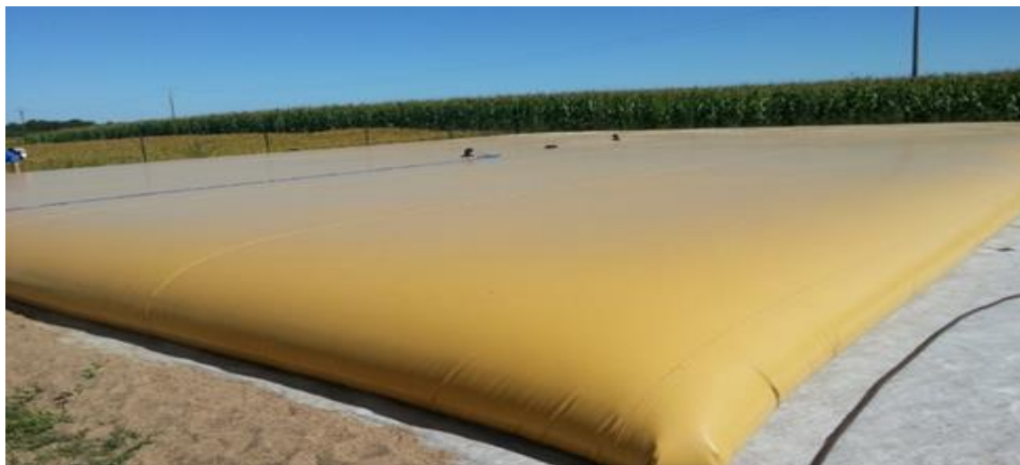
Obr. 2: Flexibilní nádrž se zásobou dešťové vody
