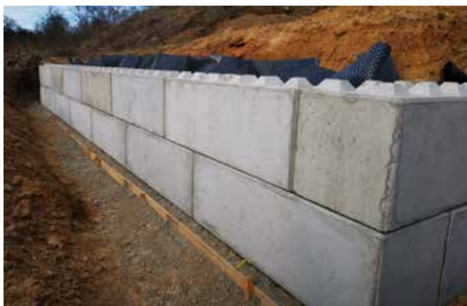
Obr. 7: Realizace opěrné stěny z betonových bloků
