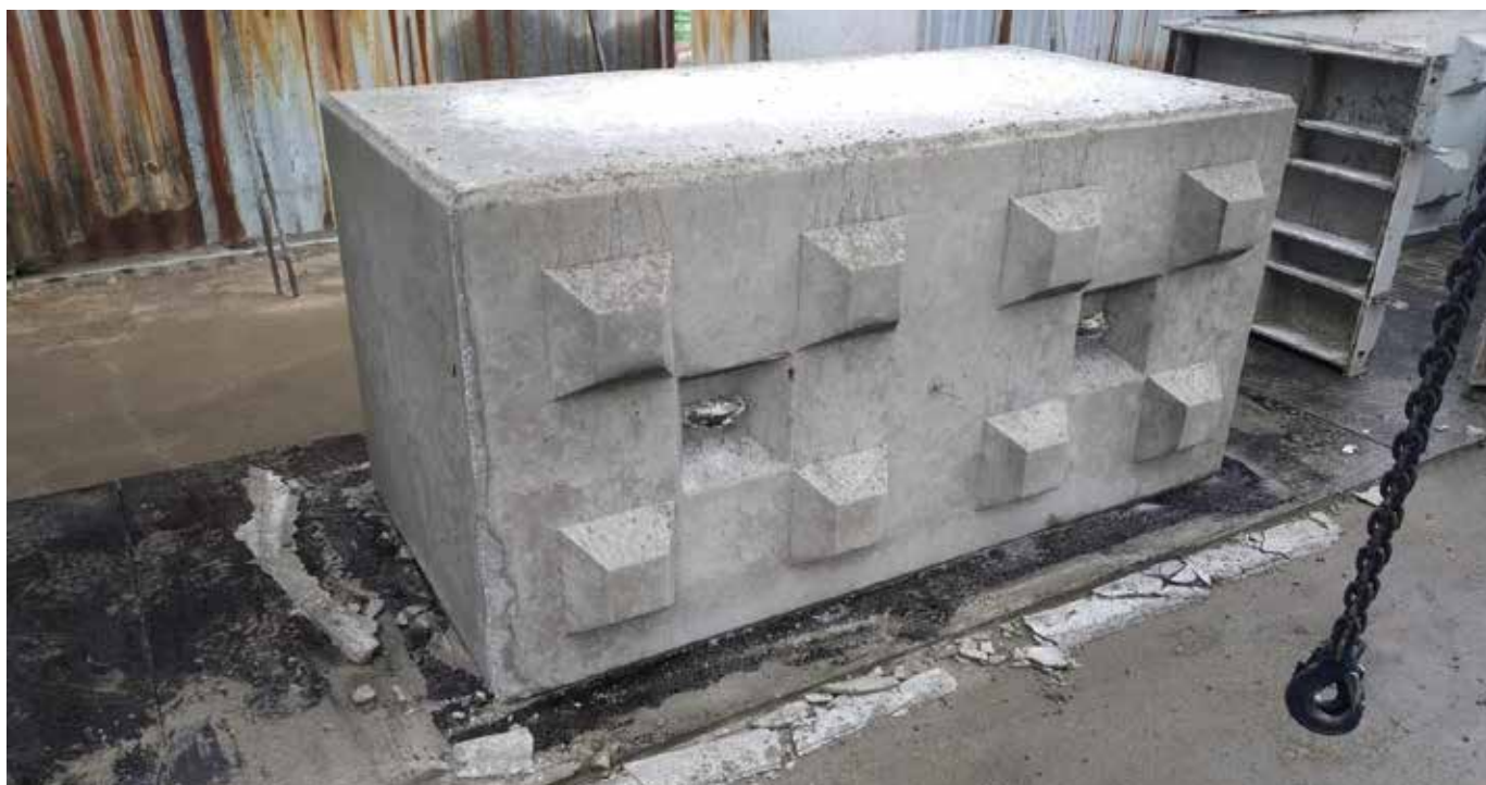
Obr. 1: Uchycení betonových bloků – oka
