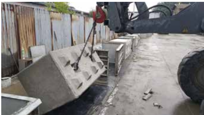
Obr. 2: Uchycení v praxi pomocí běžných vazacích řetězů s hákem
