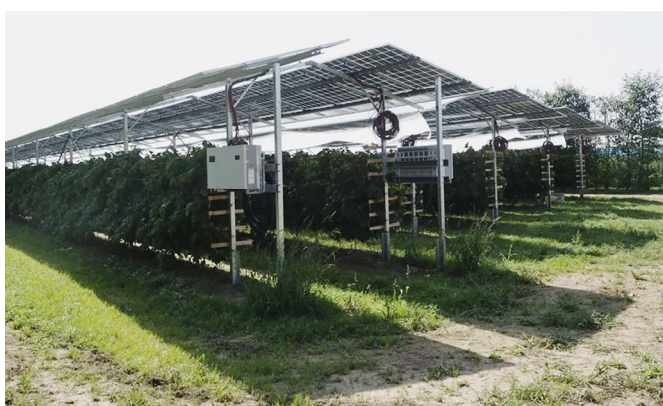
Obr. 4: Příklad horizontální agrivoltaiky (E15, 2020).
